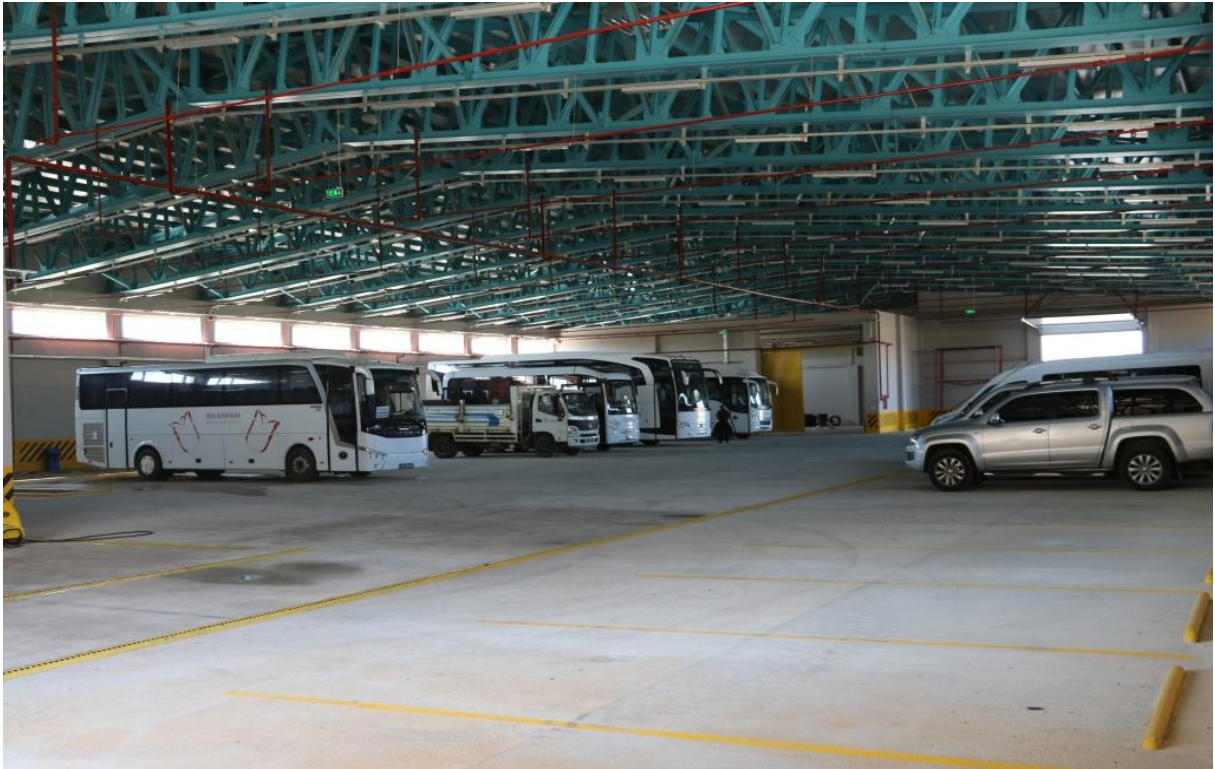
Resim 4. Hangar İç Görünüm
